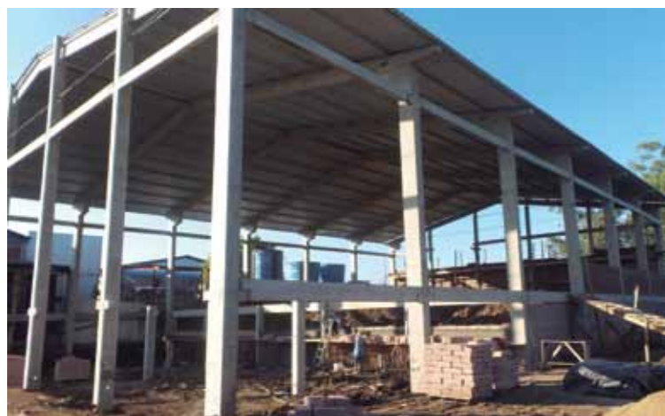
Construção de novo pavilhão da empresa Eleutério Lorenzon e Cia Ltda.
