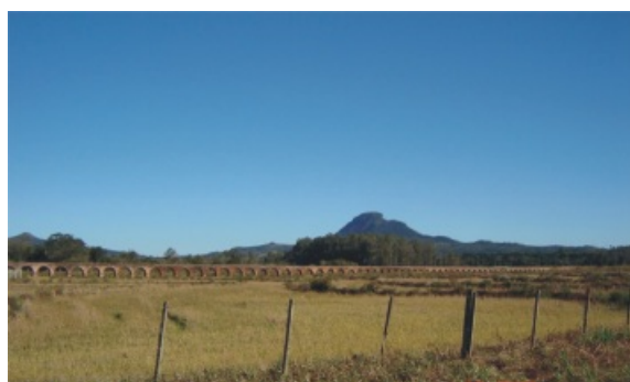
Aqueduto do Século XIX CLAITON SCHMIDT
